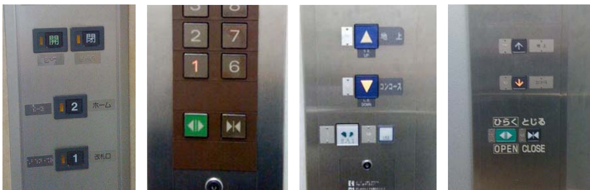
Fig. 6 漢字 矢印+カラー 矢印+大きさ+ひらがな 大きさ+矢印+カラー+ひらがな+英文
